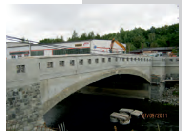
Ansicht des 1. BA während der Natursteinverblendung
