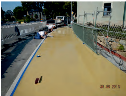
Kappeninstandsetzung BW07 im Zuge der B169
