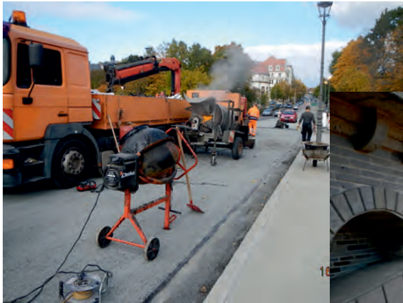
Erneuerung Belag und Fahrbahnübergänge aus Asphalt
