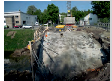
freigeräumter Bogenrücken des 1. BA oberstrom
