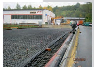
Bewehrung der Überbauplatte für den 2. BA
