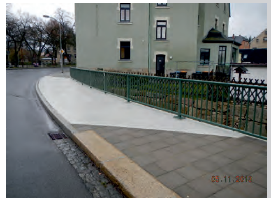
Kappeninstandsetzung BW07 im Zuge der B169
