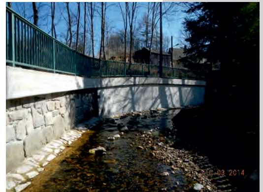
Instandsetzung Stützwand S13 im Zuge der S309-fertig
