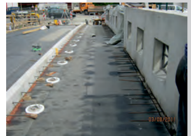
Schweißbahnabdichtung des 1. BA
