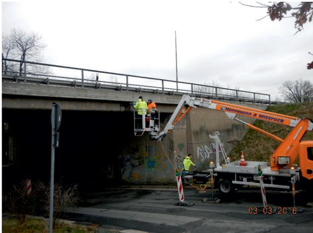
Bohrkernentnahme aus Fahrbahntafel Bw 65.3 im Zuge der B173 ,
