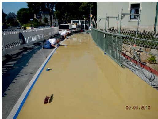
Kappeninstandsetzung BW07 im Zuge der B169
