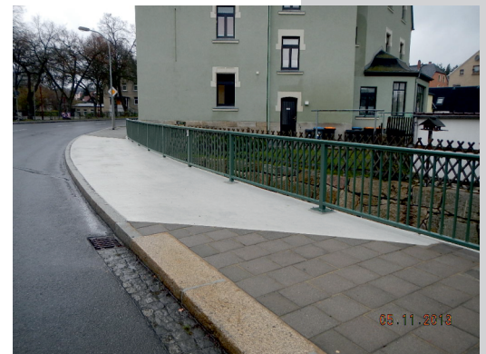
Kappeninstandsetzung BW07 im Zuge der B169
