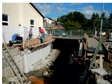
Unterbauinstandsetzung BW08 im Zuge der B169
