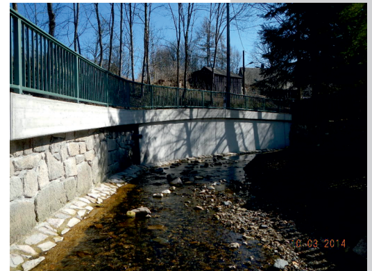
Instandsetzung Stützwand S13 im Zuge der S309-fertig
